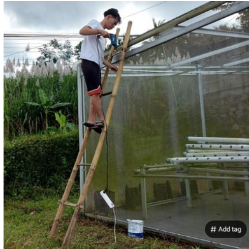
Gambar 7. Pemasangan plastik UV
