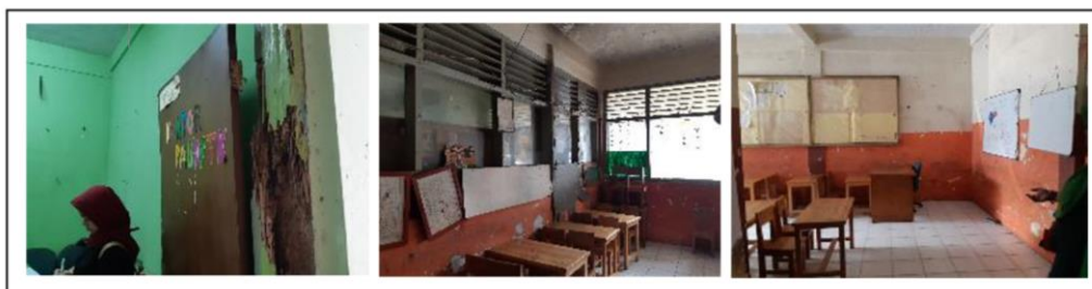
Gambar 3. Kondisi sebelum dimulai pekerjaan
